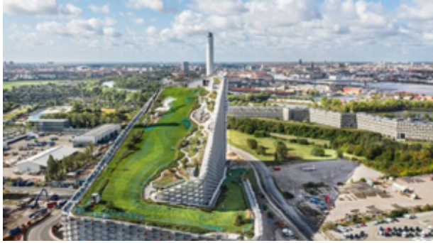
MYND 4 Amager Bakke, Danmörk. Gangsett: 2017. Stærð: 560-600.000 tonn á ári. Framleiðsla: 900-1250 GWh/ ári samtals
