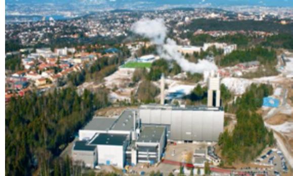
MYND 5 Klemetsrud Waste-to-Energy plant, Noregur. Gangsett: 1986. Stærð: 360.000 tonn á ári, 47 t/klst. Framleiðsla: 150 GWh/ár rafmagn, 700 GWh/ár varmi
