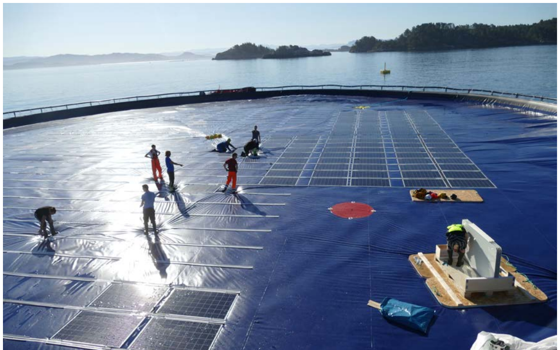
Installasjon av flytende solkraftverk blir stadig vanligere. Foto: Ocean Sun
