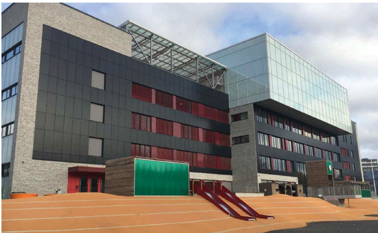
BIPV kan integreres i tak, fasader, vinduer og andre glasselementer, og produseres i ulike former og farger. Foto: IFE
