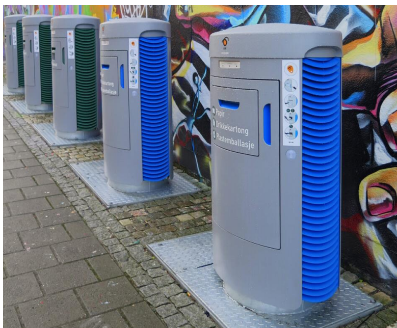
Mynd 8 Sugukerfi í Bergen (Envac, 2021). Kerfið var sett upp í miðborg Bergen árið 2015 og samanstendur nú af 7.500 metrum af lögnum og 1.200 inntakspunkta fyrir úrgang. Kerfið sinnir 30.000 heimilum fyrir 4 úrgangsflokkum og 50 tonnum á viku.
