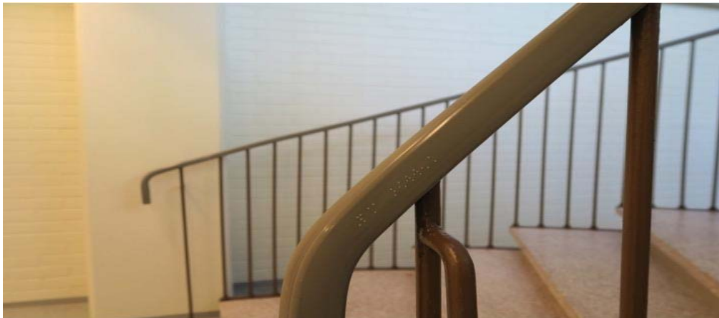
Kuva 10. Teippauksella valmistettu käsijohdeopaste
