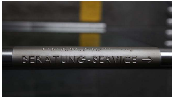
Kuva 8. Tikkurilassa käytössä oleva, alumiinista valmistettu, kaareva käsijohdeopaste
