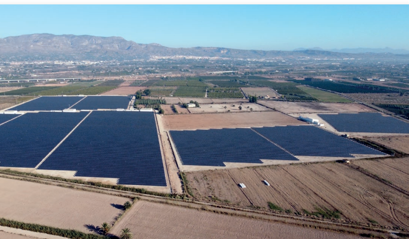
Planta solar de 13 megavatios en Crevillent (Alicante)
