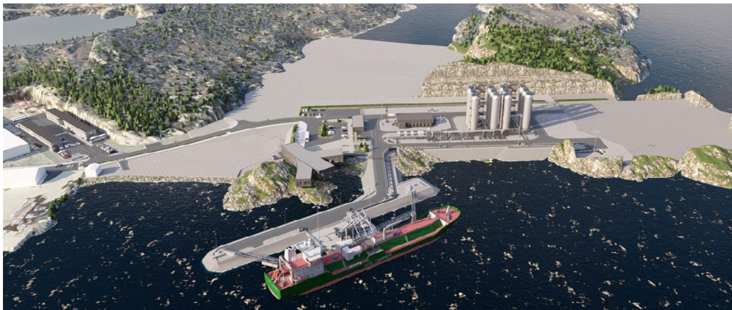
LANGSKIP/NORTHERN LIGHTS: Det er planar om å investere millardar på fullskala CO2-fangst og lagring i Noreg. Klimagassen skal fraktast med tankskip til Kollsnes i Øygarden. Der skal den mellomlagrast i eit tankanlegg. Så skal den pumpast gjennom eit 110 kilometer langt røyr ut i Nordsjøen. Og vidare til lagringsplassen over tre kilometer under havbotnen. Ill.: Northern Lights JV
