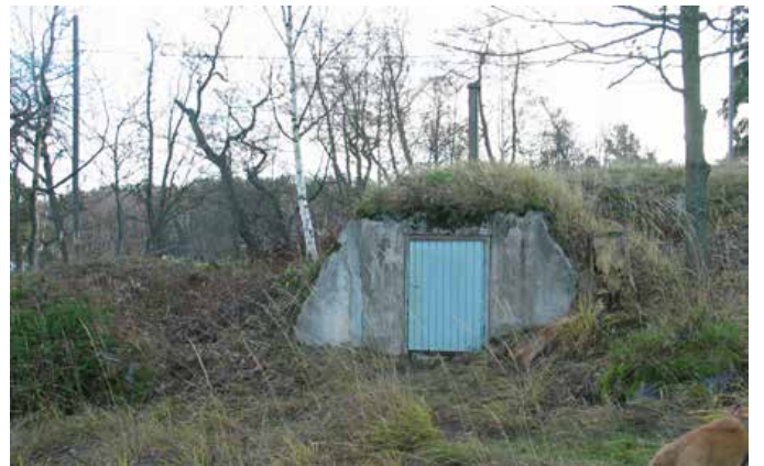
Kumpareeseen kätkeytyvä maakellarin sisäänkäyntisivun muurit on valettu betonista.
