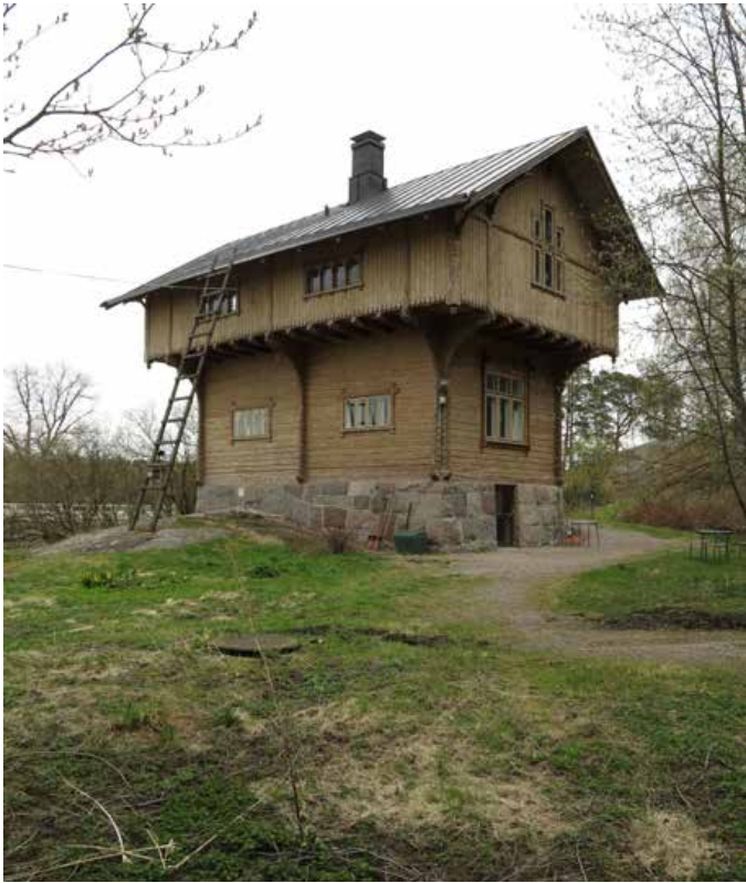
Frithiof Mieritzin 1890 suunnittelema Saarenvartijan rakennus Seurasaarella edustaa samaa norjalaisvaikutteista arkkitehtuurisuuntausta kuin Stenkullan huvila.
