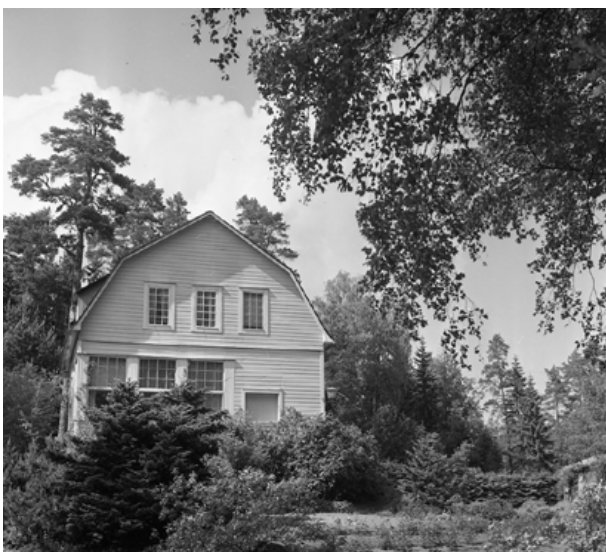
Puutarha 1960-luvun lopulla. Verannan ulkoportaat on purettu. Hbl
