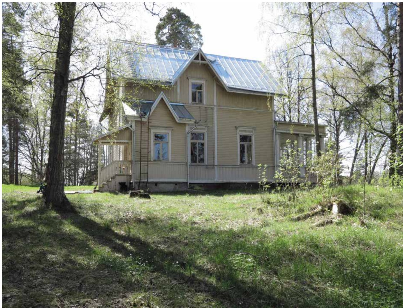
Julkisivun 1890-luvun huvila-arkkitehtuurille ominaiset piirteet listoituksineen ja T-mallisine ikkunoineen ovat parhaiten säilyneet keittiön sisäänkäyntipuolella.
