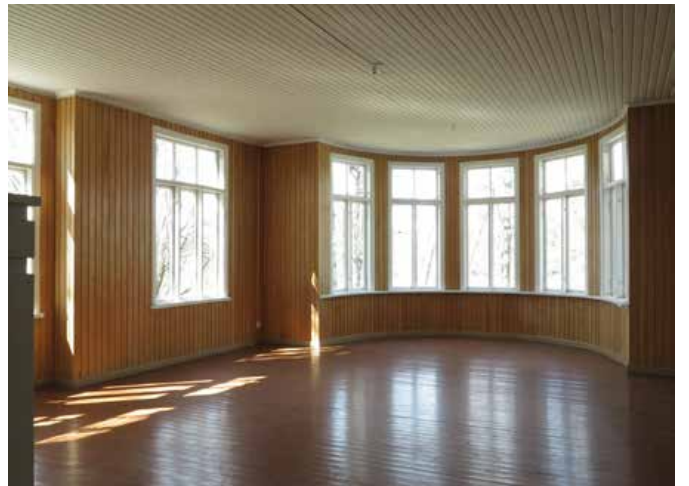
Kaarevamallinen lasikuisti kuuluu laajennusosaan. Uusimman korjauksen jälkeen sisäverhoaus on huvilan arkkitehtuurille epätavallista lakattua paneelia.
