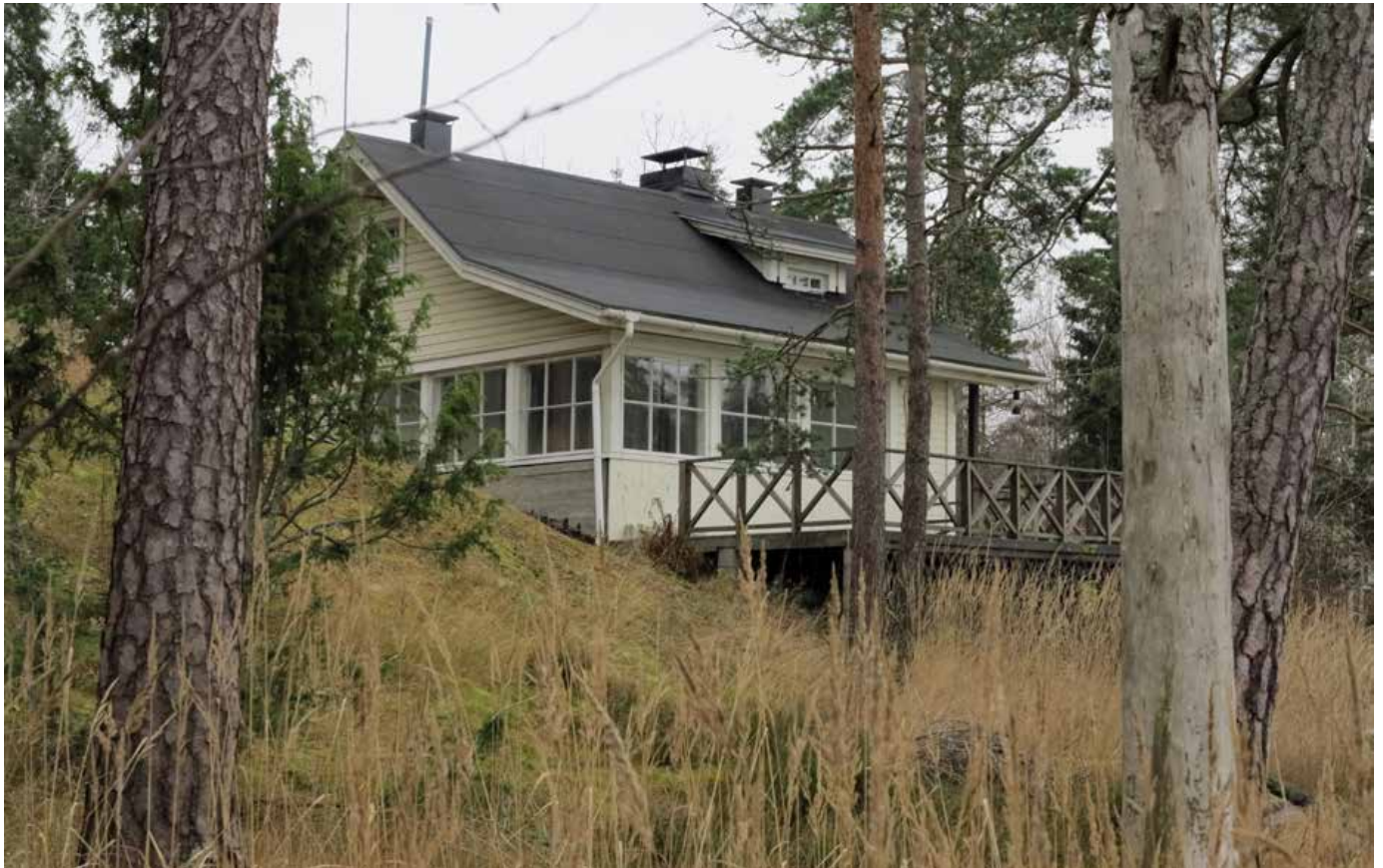
Rannan puoleisen rakennuksen pohjoisivulla on avoin terassi.
