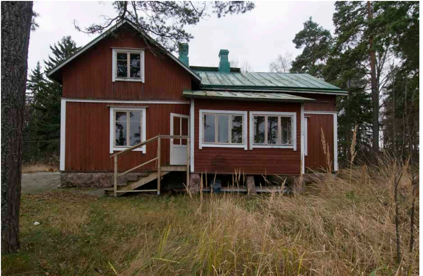
Rannan puoleinen kuisti ei ole alun perin kuulunut asuinrakennukseen. Kari Hakli 2011
