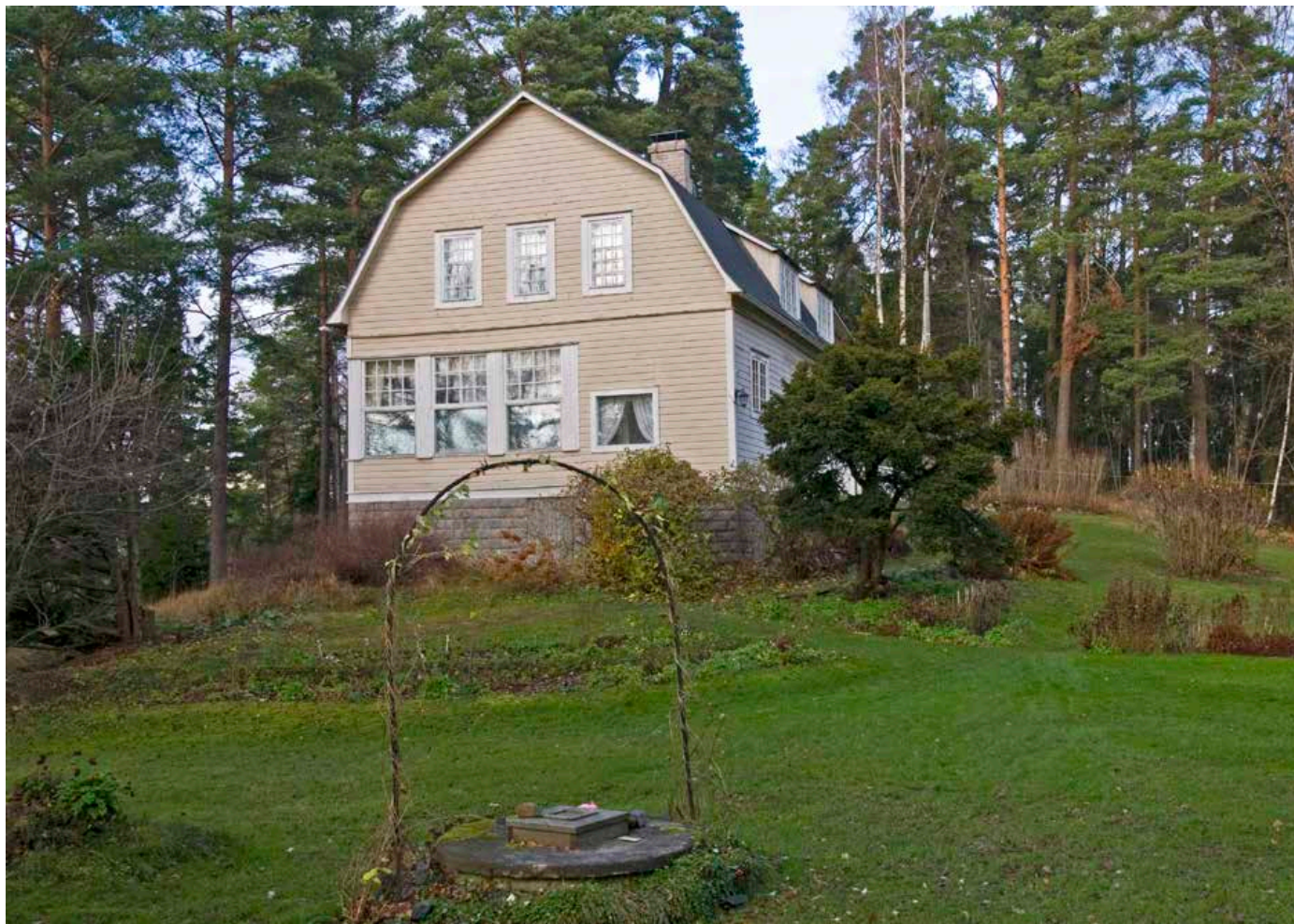
Kaareva koristeistutus on säilynyt verannan edessä. Verannalta puutarhaan johtavat portaat on purettu. Kari Hakli 2011
