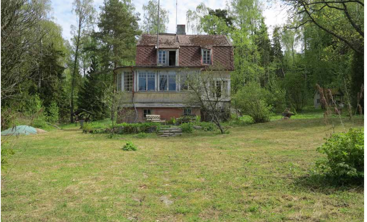
Huvilan luoteissivulla on puoliiympyrän muotoinen tasanne, jonka keskilinjasta lähtee kivetty käytävä kohti rantaa.
