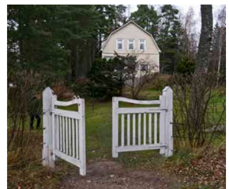
Etelärajalle, nykyiselle yhteyslaiturille johtava tien varrelle on istutettu pensasaita. Aidassa on 1910- ja 1920-luvuille tyyppilinen, kaarevalinjainen säleportti.
