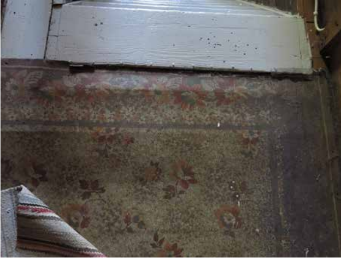
Säilynyttä painokuvioista linoleumimattoa.
