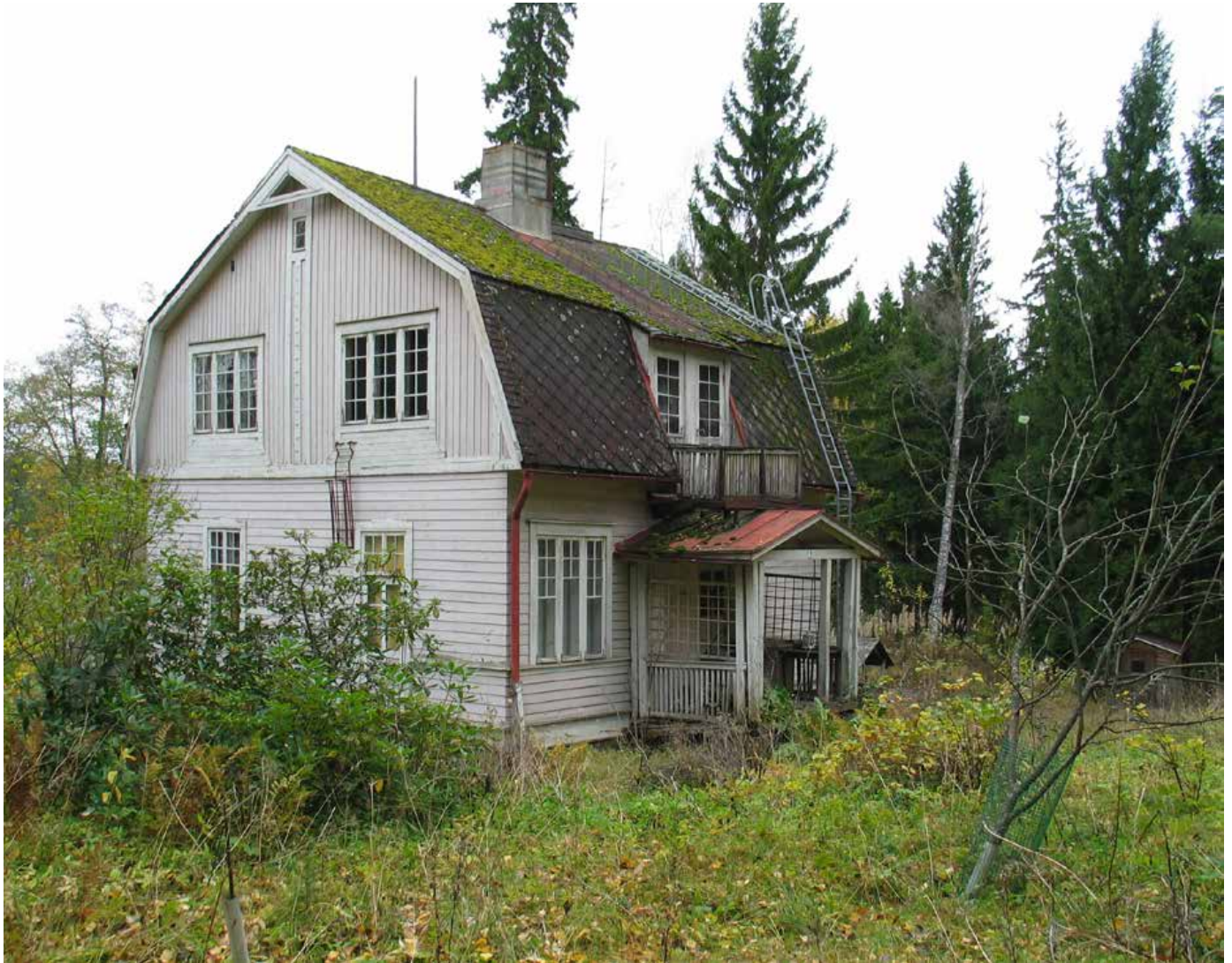
Perushahmo on 1910–1920-luvuilla suosittua mallia; kiinteä, suorakaiteen muotoiselle sokkelille rakennettu mansardikattoinen huvila.
