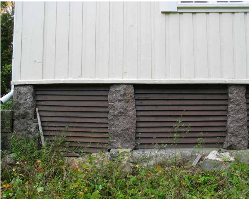
Perustuksessa on käytetty vaihtelevasti kivipilareita, umpinaista sokkelimuuria ja rapattua tiilimurausta.
