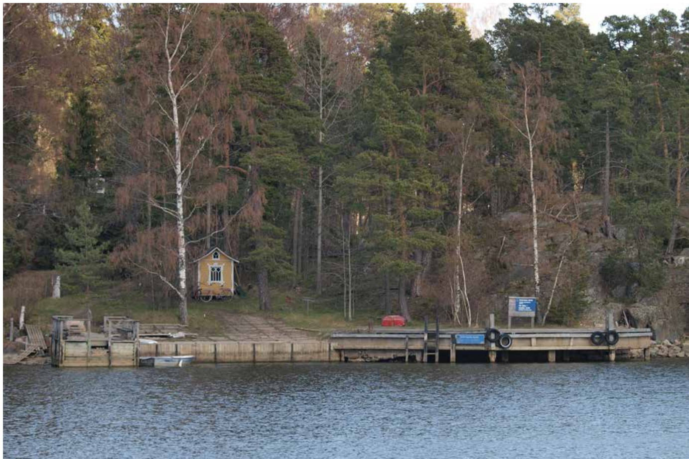
Alkon aikaista satamalaituria on pidennetty nykyistä yhteysliikennettä palvelevalla järeällä laiturilla. Vasemmalla näkyvä hirsiarkkulaituri on vielä käytössä.
