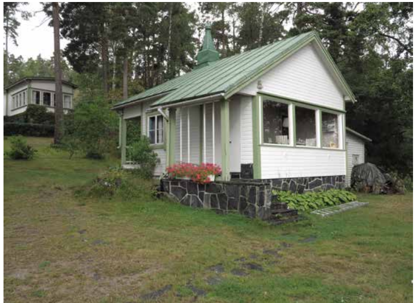
Saunarakennuksessa on 1930-1950-lukujen arkkitehtuurille tyypillisiä yksityiskohtia, kuten sokkelin liuskekiviverhous ja nauhaikkuna.
