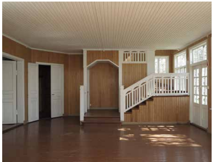
Uusi sisäporras on rakennettu laajennuksen puolelle. Yksityiskohtien perusteella laajennus näyttää olevan 1920-luvun vaihteesta.
