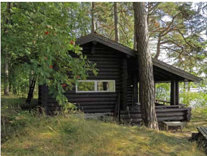
Saunarakennus on luontevasti sovitettu rinteeseen porrastuvan sokkelin avulla.
