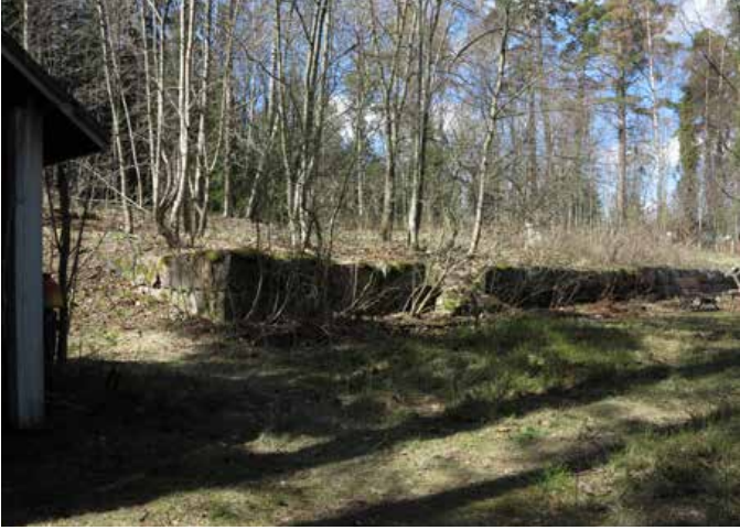
Kiviharkoista rakennettu tukimuri ylemmän puutarhaterassin reunalla. Vasemmalla leikkimökki.
