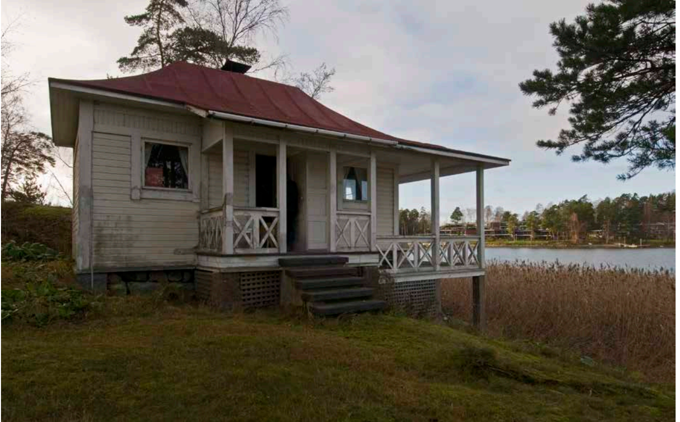
Saunan hirrestä rakennettua ydintä täydentävät avoimet kuistit kahdella sivulla.
