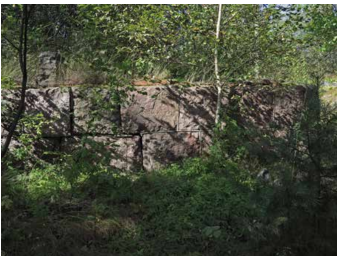
Rauniohuvilan perusmuuri on tehty jäleistä graniittiharkoista.
