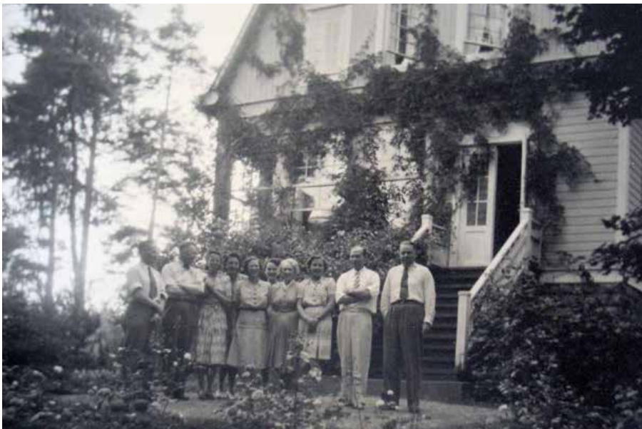
Päädyssä sijaitsevan verannan ulkoportaat 1950-luvulla. Yksit.
