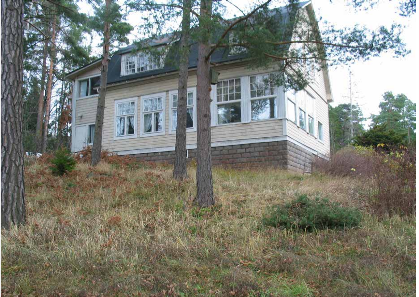
Näkymä lounaasta rannan suunnalta. Vasemmalla alkuperäiseen rakennusvolyyymiin lisätty porras.
