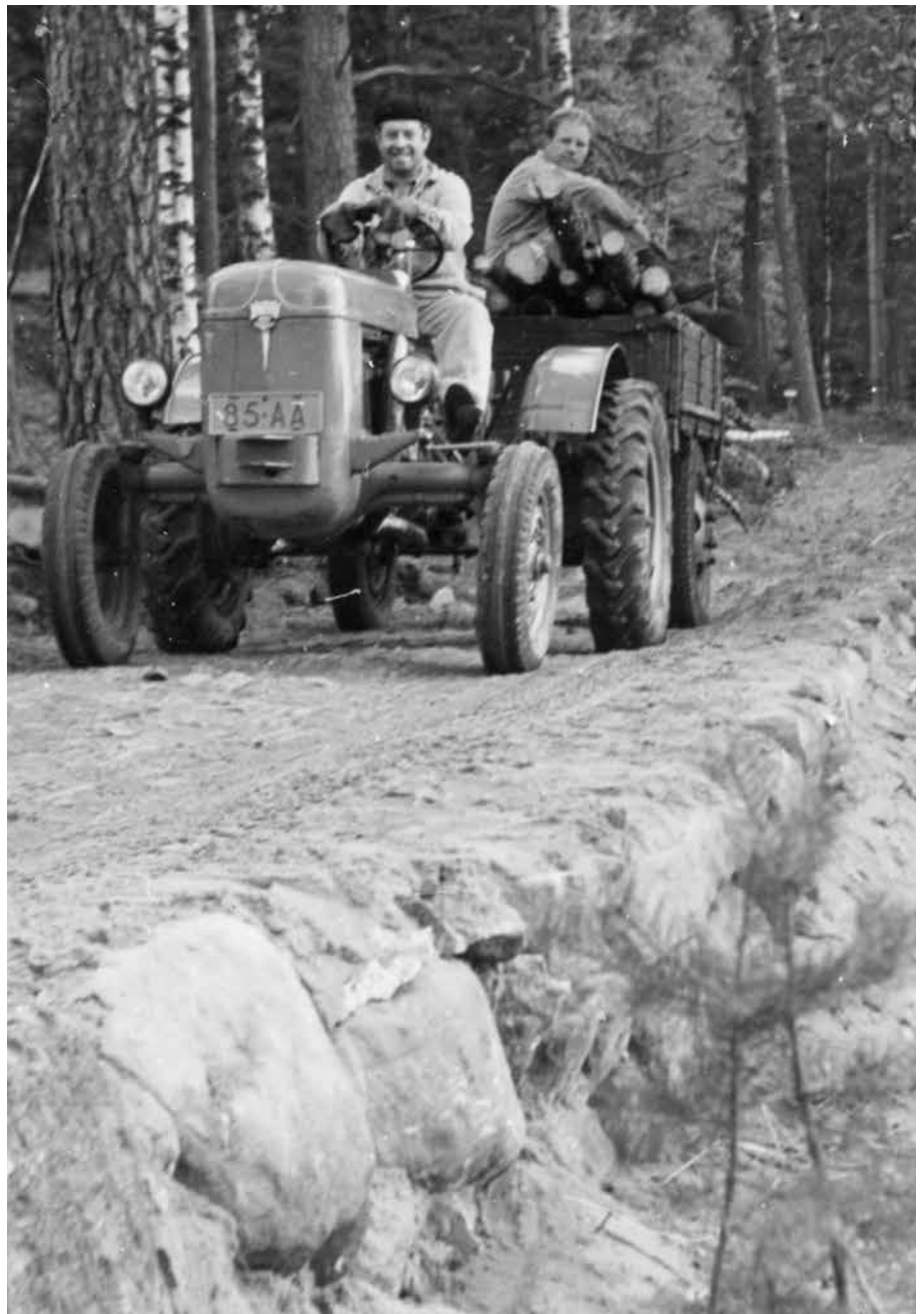
Korkea kivipengerryks reunustaa 1950-luvulla rakennettua uutta ajotietä Drakuddenin suuntaan. Altian arkisto
