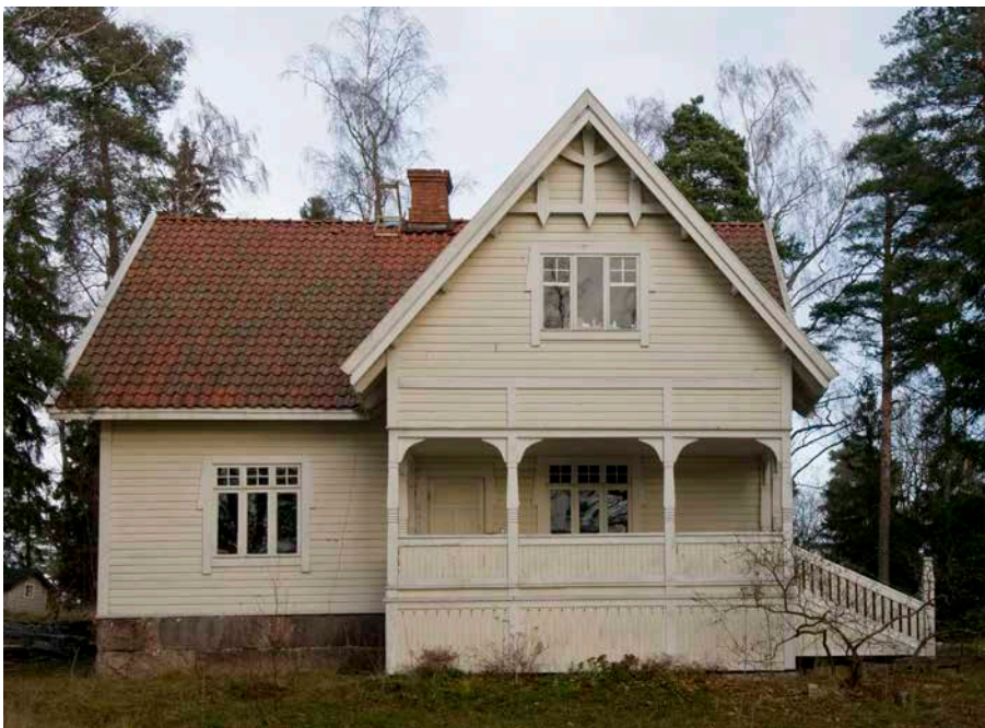
Villa Draknäsin päätyosassa on Stenkullan kaltainen koristeaihe.
