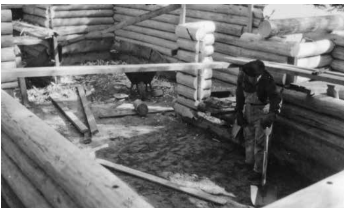
Saunan rakentaminen. Altian arkisto
